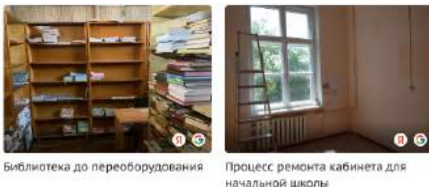
Рисунок 7. Кабинеты до переоборудования
