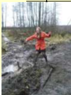
До подсыпки грунта
