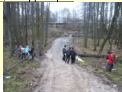
После подсыпки грунта
