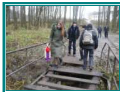
Мост через Буяновский ручей
