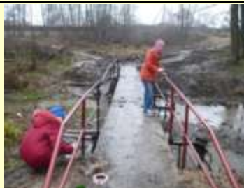
Покраска перил мостика
