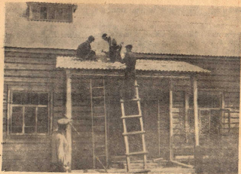
Звено Виктора Рубанова кладет последний лист шифера
